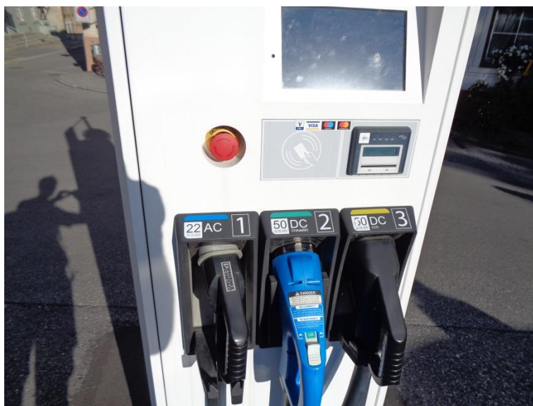
Obr. 4 Příklad provedení nabíjecího stojanu s nabíjecími kabely pro připojovací standardy Mennekes (22 kW), CHAdEMO (50 kW) a CCS Combo 2 (50 kW)
